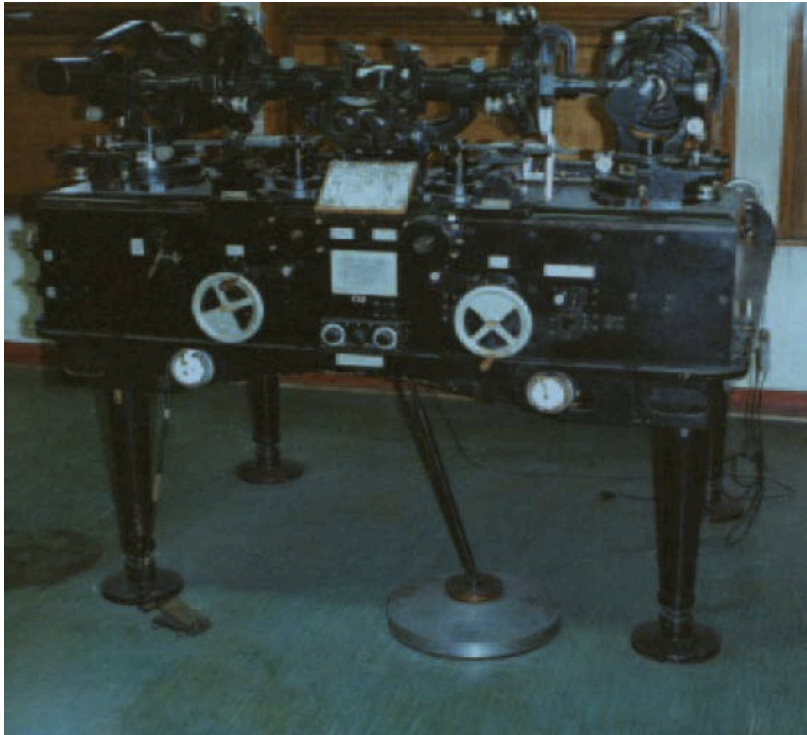
Le stéréotopographe Poivilliers type A, acquis par la Société française de stéréotopographie, 1934 (Revue XYZ)
