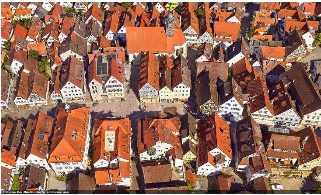
Image 9-10 : Ci-dessus : centre-ville de Marbach généré uniquement à partir d'images obliques ; ci-dessous : avec l'ajout de la caméra nadirale
